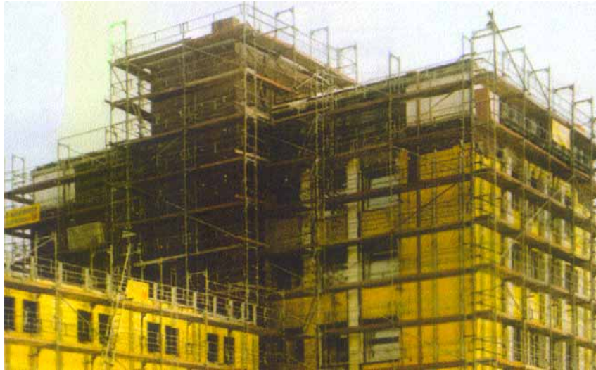
Σχήμα 8.4. Αναδρομική εξωτερική θερμομόνωση κτιρίου – 1996 στη Γερμανία.
