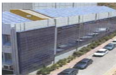
Σχ. 6. Πανεπιστημιακό κτίριο Ε.Μ.Π. στην Αθήνα
