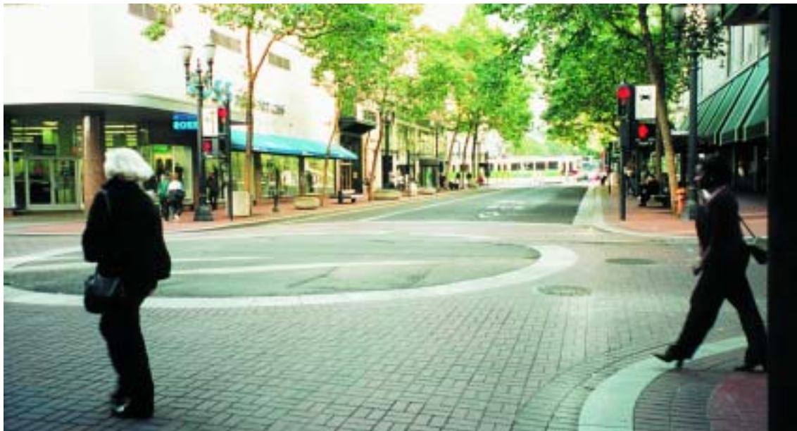
Φωτ. 1.23. Portland, Oregon. ΗΠΑ. Διαμόρφωση διασταύρωσης με κόκκινους κυβόλιθους και με λευκές πλάκες που σχηματίζουν έναν κύκλο στο κέντρο της. Η διασταύρωση γίνεται έτσι πιο εύκολα αντιληπτή από τα αυτοκίνητα που την προσεγγίζουν και συμβάλλει θετικά στην αισθητική του δρόμου. Για να ενισχυθεί το αισθητικό αποτέλεσμα, η περιοχή του κύκλου έχει ανυψωθεί περίπου στο ύψος της σάθμης των πεζοδρομίων. Διακρίνεται ο αποκλειστικός χώρος κίνησης των λεωφορείων που αφήνει μόνο μια λωρίδα για την κίνηση των ιδιωτικών αυτοκινήτων.
