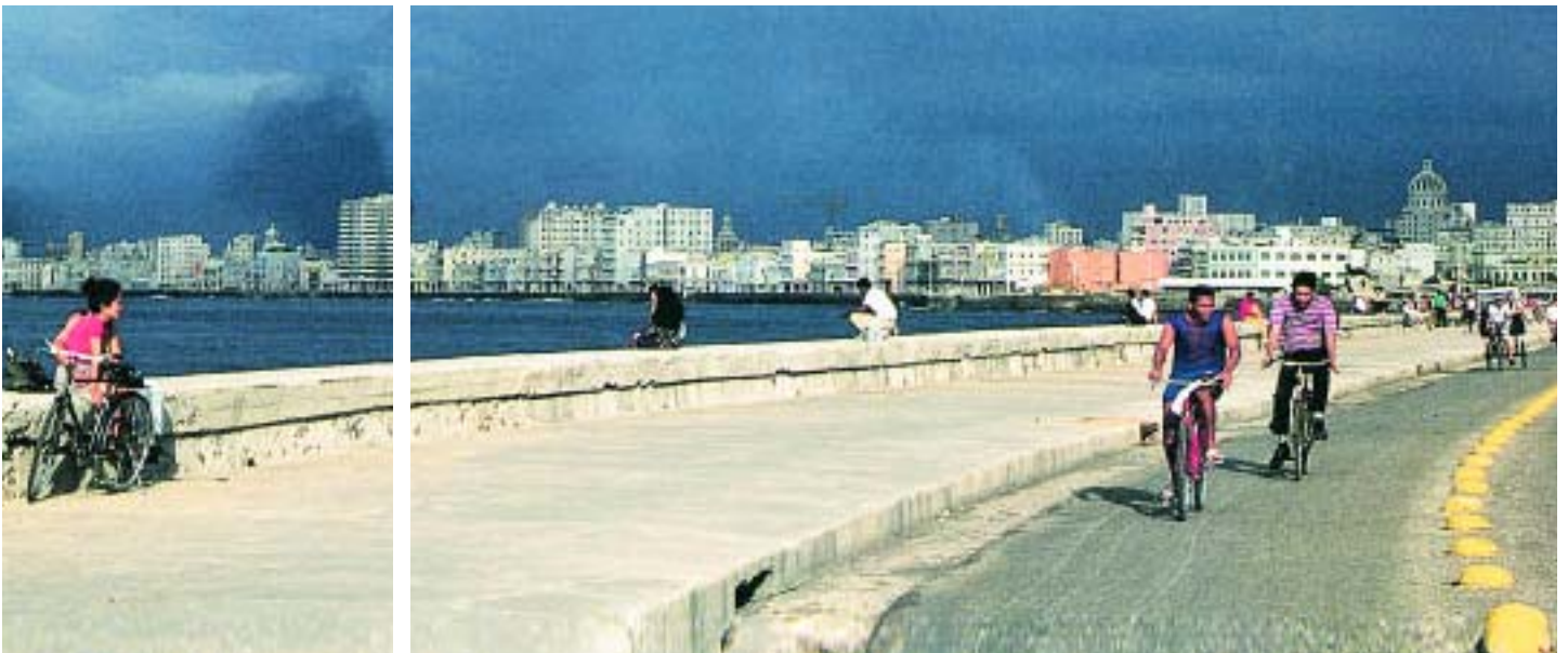
Φωτ. 1.13. Havana. Κούβα. Λωρίδα ποδηλάτου, πλάτους περίπου 2,5 μ. που ορίζεται από σειρά ημισφαιρικών, κίτρινων στοιχείων από τσιμέντο. Σημειώνεται ότι το διακεκομμένο διαχωριστικό ανάγλυφο είναι προτιμότερο από το συνεχές διότι δίνει τη δυνατότητα στο ποδήλατο να μεταίθεται στη λωρίδα των αυτοκινήτων όταν η δική του έχει διακοπή από κάποιο αυθαίρετα σταθμευμένο όχημα.
