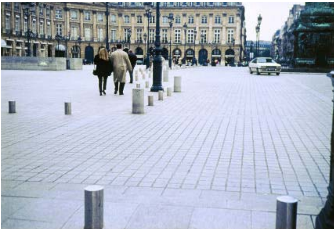
Φωτ. 1.32. Paris. Γαλλία. Διαμόρφωση πλατείας σε ενιαία στάθμη. Ο διάδρομος διελευσης των αυτοκινήτων οριοθετεί - ται διακριτικά με ανοξείδωτους πασσάλους μικρού ύψους. Αξίζει να σημειωθεί η προσπάθεια αποφυγής της μονοτονίας με διαφοροποίηση των πασσάλων σε ύψος και σε διατομή. Επίσης, οι αποστάσεις μεταξύ τους είναι 'τυχαίες'.
