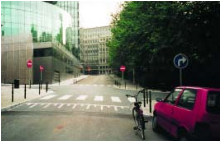
Φωτ. 1.29. Bruxelles. Βέλγιο. Ανυψωμένη διασταύρωση στη στάθμη των πεζοδρομίων. Θα πρέπει να παρατηρηθεί ότι η κατακόρυφη σήμανση λόγω του υπερβολικού μεγέθους των πινακίδων επιβάλλεται άκομψα στην αισθητική του χώρου.
