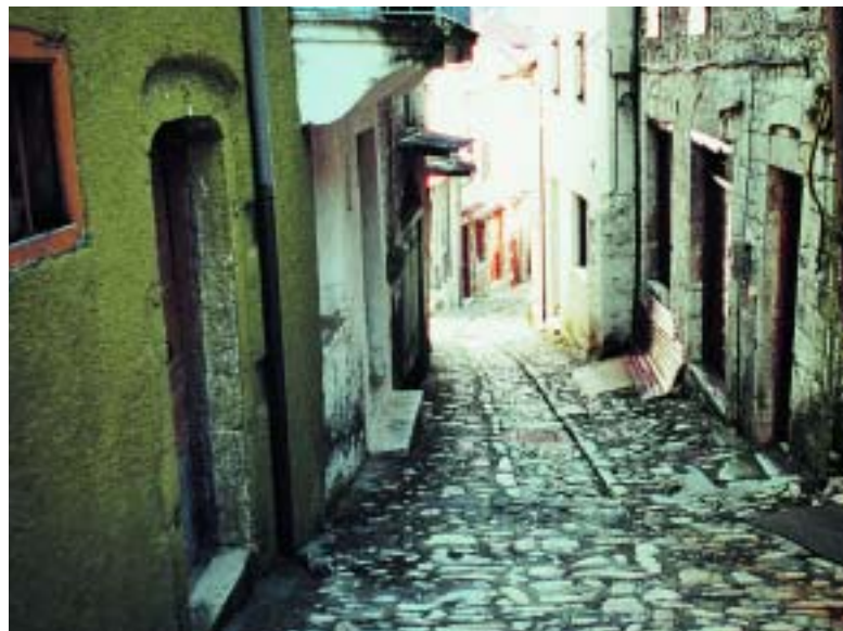
Φωτ. 1.24. Δημητσάνα. Γορτυνία. Επεξεργασμένη διαμόρ - φωση κεντρικού ορθογώ - νιου αυλακιού για τα νερά σε έντονα κατηφορικά λιθόστρωτο του χωριού.
