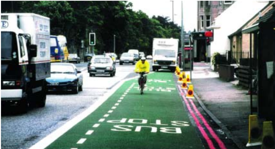
Φωτ. 1.22. Edinburgh. Σκωτία. Αποκλειστική λωρίδα για λεωφορεία και ποδήλατα. Η περιοχή της στάσης των λεωφορείων είναι βαμμένη με πράσινο θερμοπλαστικό χρώμα.
