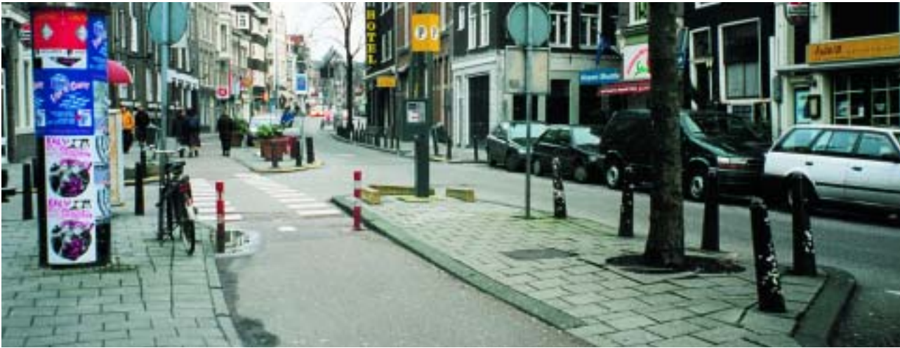
Φωτ. 1.16. Amsterdam. Ολλανδία. Διαμόρφωση ήπιας κυκλοφορίας με αποκλειστικό διάδρομο για το ποδήλατο και μεγάλου πλάτους βαθιά διαχωριστική νησίδα. Η υψομετρική διαφοροποίηση μεταξύ όλων των επιμέρους τμημάτων του δρόμου είναι πολύ μικρή ώστε αισθητικά να αποκτάται μια ενιαία εικόνα.
