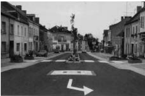
Φωτ. 1.17. Doyet. Γαλλία. Διαμόρφωση ήπιας κυκλοφορίας. Οριζόντια σήμανση και σχεδιασμοί επί του οδοστρώματος με χρήση χρωματιστών κυβόλιθων. (Η φωτογραφία παραχωρήθηκε από το CETUR και περιλαμβάνεται στην έκδοση Ville plus sûre – Quartiers sans accidents , σελ. 140).
