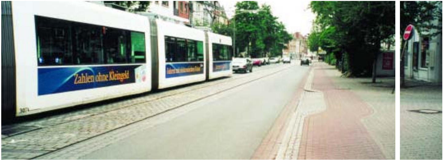
Φωτ. 1.28. Bremen. Γερμανία. Στη Βρέμη, συστηματικά, οι λωρίδες ποδηλάτου έχουν κατασκευαστεί επί των πεζοδρομίων. Εδώ φαίνεται η διέλευση ποδηλατόδρομου από διασταύρωση με δρόμο υποδεέστερου ρόλου. Η λωρίδα του ποδηλάτου και το πεζοδρόμιο δεν διακόπτονται στη διασταύρωση και διατηρούν τη στάθμη τους. Ο ποδηλατόδρομος κάμπτεται για δύο λόγους: πρώτον, για να υπάρξει χώρος για την κατασκευή της ράμπας και δεύτερον, για να υποχρεωθεί ο ποδηλάτης να μειώσει ταχύτητα στην περιοχή της διασταύρωσης.
