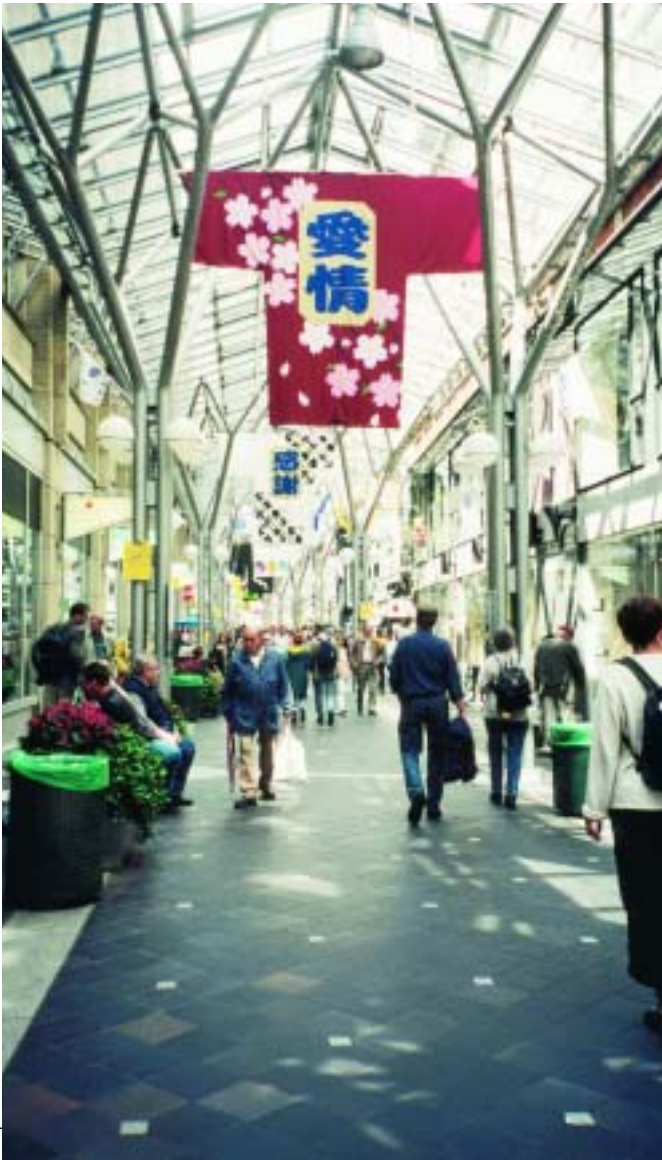
Φωτ. 1.8. Βρεμεν. Γερμανία. Μεταλλική μεγαλοκατασκευή για την κάλυψη εμπορικού πεζοδρομου στο κέντρο της πόλης.
