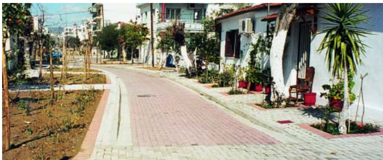
Φωτ. 4.4. Βόλος. Οδός Ρήγα Φεραίου. Διάδρομος κίνησης οχημάτων και ποδηλάτων σε καμπύλη χάραξη
