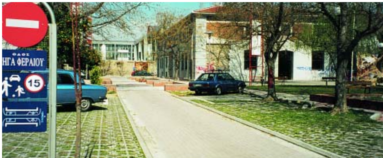
Φωτ. 4.3. Βόλος. Οδός Ρήγα Φεραίου. Διακοπή διαπερόπτητας με παρεμβολή πλήρως πεζοδρομημένου τμήματος με καθιστικά. Ο διάδρομος κίνησης εξυπηρετεί την πρόσβαση στις θέσεις στάθμευσης. Είναι ενδιαφέρουσα η πληροφοριακή σήμανση ως προς τη στάθμευση.
