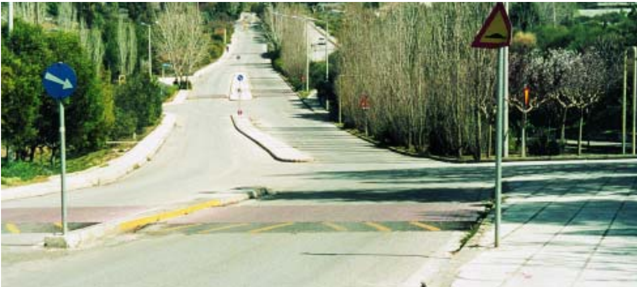
Φωτ. 4.35. Πολυτεχνειούπολη. Αθήνα. Διαδοχικά σαμαράκια μορφής πλατώματος, περίπου στη στάθμη του πεζοδρομίου, για τη μείωση των ταχυτήτων. Η παρεμπόδιση της απορροής των νερών αποφεύγεται με διακοπή του πλατώματος 5 εκ. προ του κρασπέδου, στη θέση του ρείθρου.
