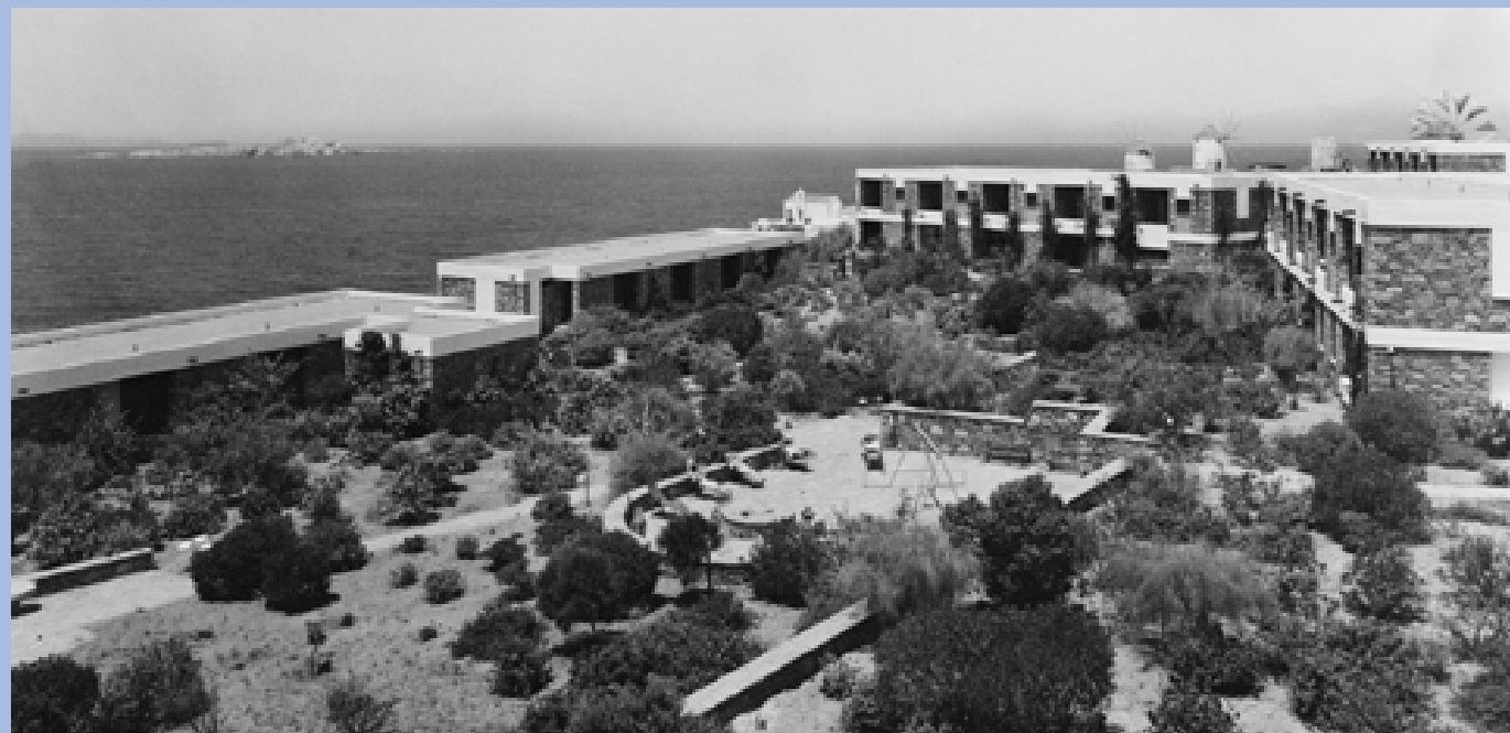
πάνω: Μοτέλ Ξενία Καλαμπάκας, αρχ. Α. Κωνσταντινίδης [από το βιβλίο Άρνης Κωνσταντινίδης: Μελέτες+Κατασκευές] κάτω: Ξενοδοχείο Ξενία Μυκόνου, αρχ. Α. Κωνσταντινίδης [από το αρχείο της Έκθεσης Τοπία εκμοντερνισμού – Ελληνική αρχιτεκτονική 1960 και 1990]
