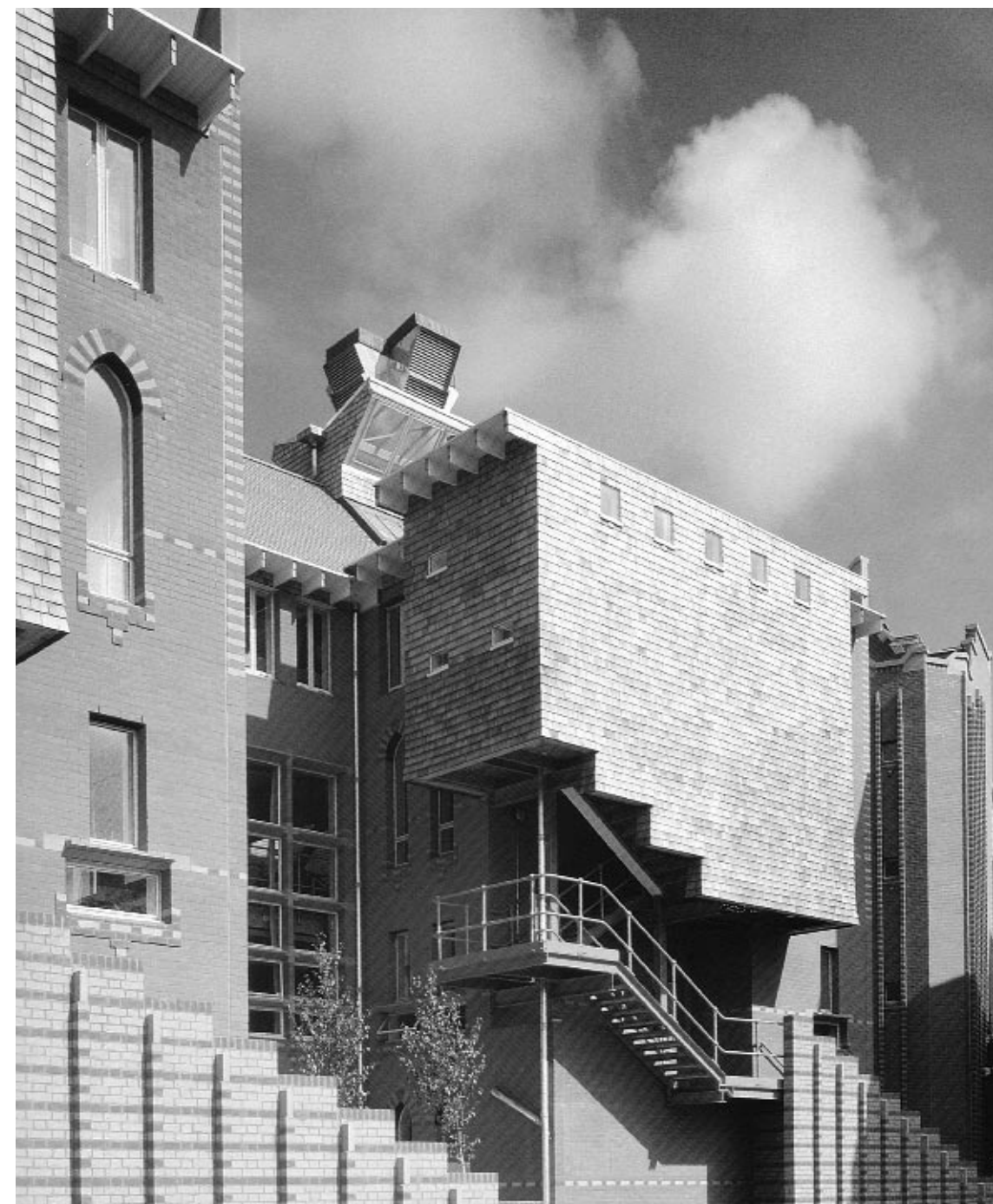
κάτω δεξιά και δίπλα αριστερά: De Montfort University (School of Engineering and Manufacture), Leicester, Βρετανία – Short Ford & Associates πάνω: De Montfort University. Τομή
